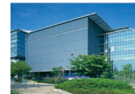
Yokohama Data Center II
