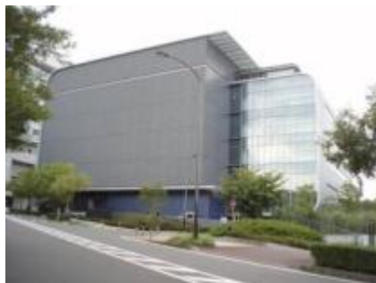
横浜第二データセンター (竣工)2007年
