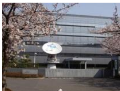
日吉データセンター (竣工)1985年
