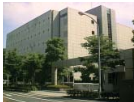
横浜データセンター（NRIデータサービス）
