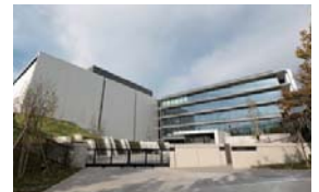
③東京第一データセンター外観
