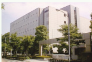
横浜第一データセンター
