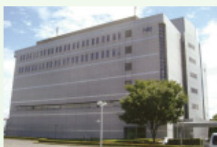
大阪データセンター
