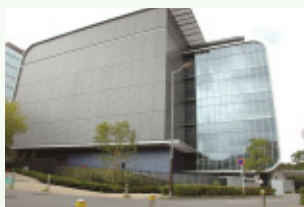
横浜第二データセンター
