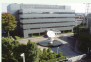
日吉データセンター
