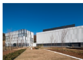
大阪第二データセンター
