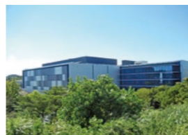
東京第一データセンター
